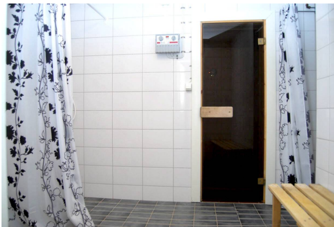
Nyrenoverat duschrum utanför bastun
