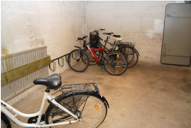
Cykelutrymmen i källaren
